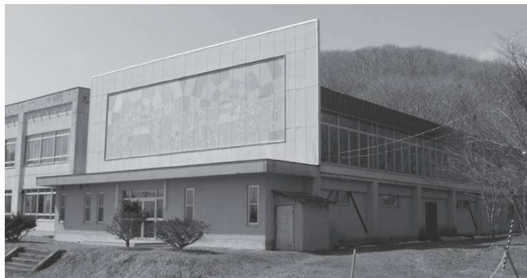
現状、耐震補強が難しい旧節婦小学校体育館
