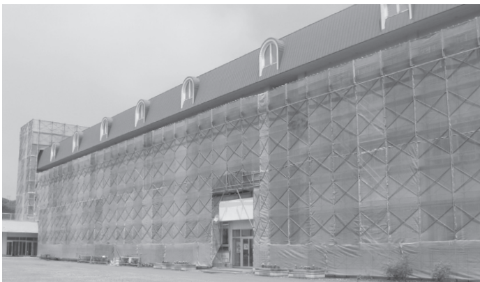
工事が進む新冠中学校の大規模改修
