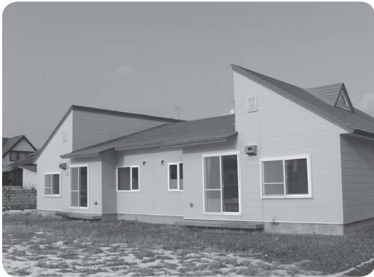
塗装工事を取り止めた東町職員住宅
