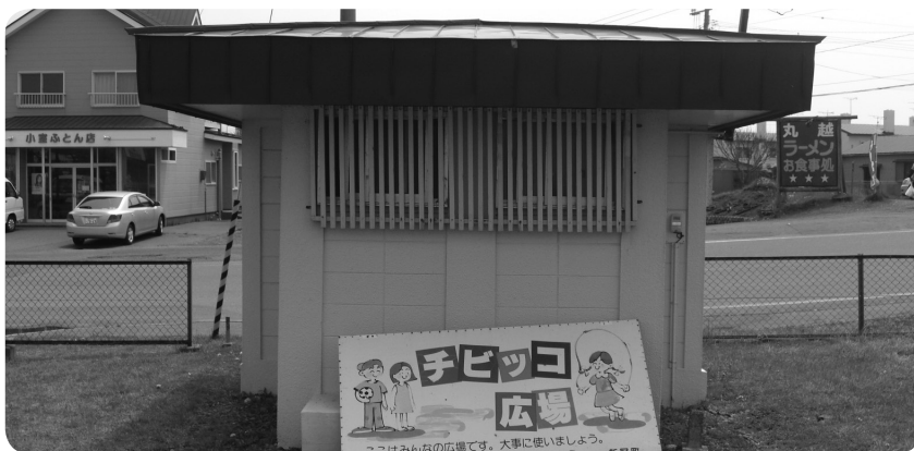
解体撤去される公衆トイレ
