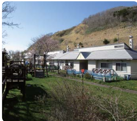
改修が進められてる節婦ふれあいタウン
