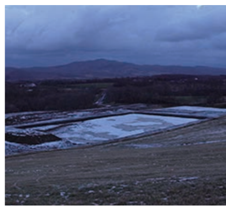
日高食肉センター建設予定地の現況
