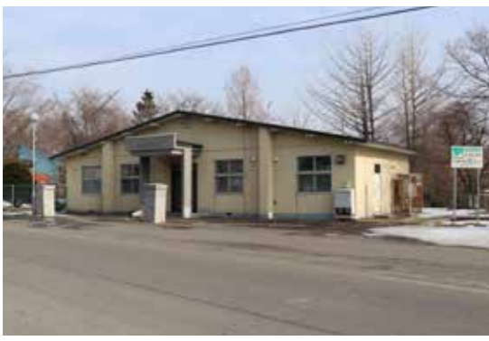
災害時は役場の災害対策本部としての利用を想定している泊津生活館
