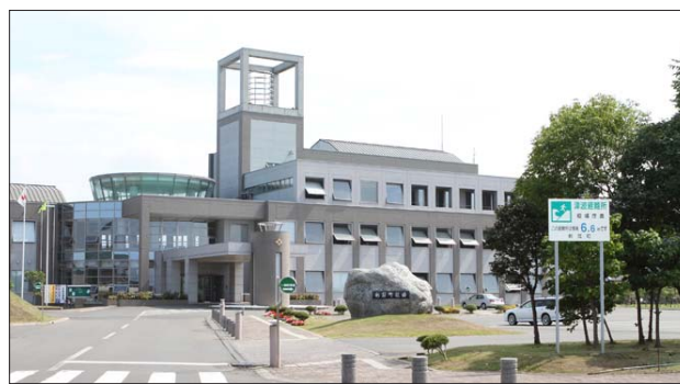
役場庁舎前駐車場 標高 6.6 メートル
