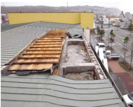
▲暴風で破損した本町多目的交流センターの屋根
