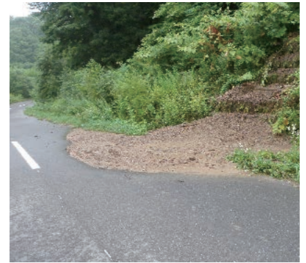
小規模土砂流出が発生した町道
