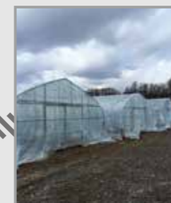
3月中旬 ハウス整備② ビニールかけ作業
