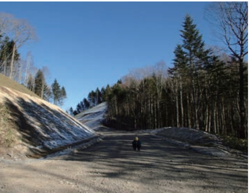
今年度の完成をめざす東川の工事現場
