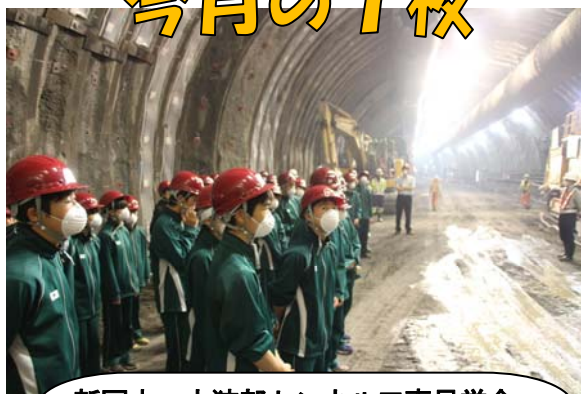
新冠中～大狩部トンネル工事見学会 トンネル工事の現場を直に見学する貴重な見学会となりました。丁寧に説明していただいた工事関係者の皆さん、ありがとうございました。
