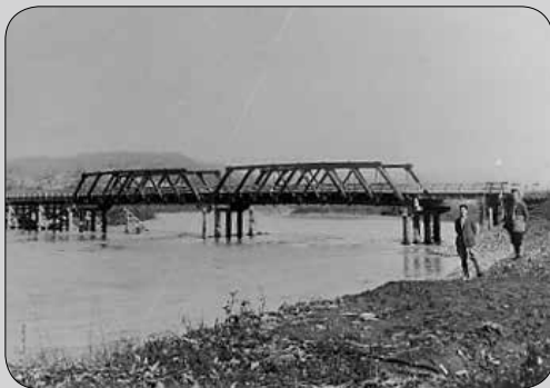
昭和 11 年頃の新冠大橋
