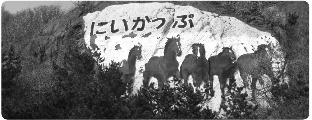
一部はがれ等が生じている馬像壁画
