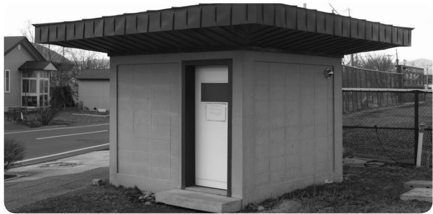
改修が望まれる町民グラウンド用トイレ
