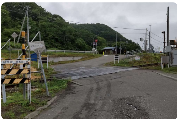
改善が必要と思われる「節婦大踏切」付近
