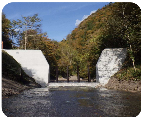
太陽地区に設置のスリットダム
