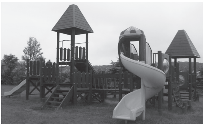
改修が必要とされるレ・コードパーク複合遊具
