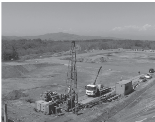
日高食肉センターの工事現場
