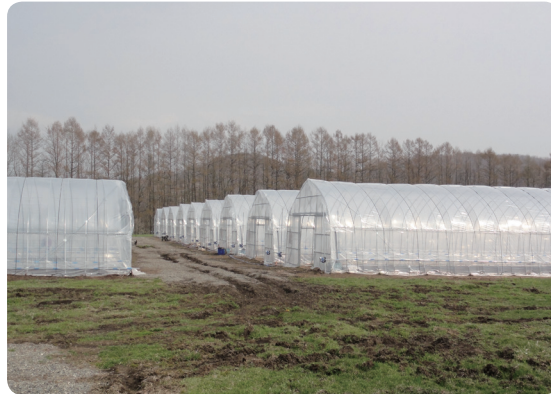
復旧されたビニールハウス
