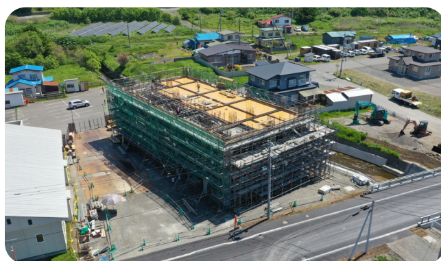
津波避難タワーの工事状況
