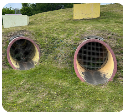
閉鎖中のトンネル状通路
