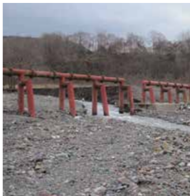
現在の比字川上流の様子（流木が撤去された状況）
