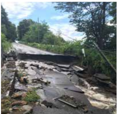
平成28年8月に発生した災害で被害を受けた町道
