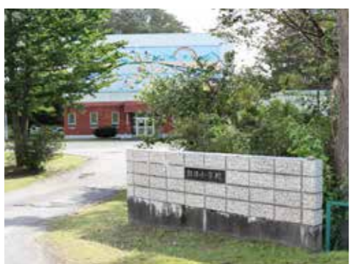
工事後の朝日小学校校門ブロック塀
