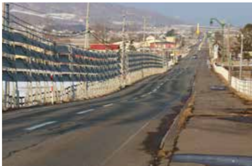
整備要望のあった高江～市街地間の道路 （道道滑若新冠停車場線）
