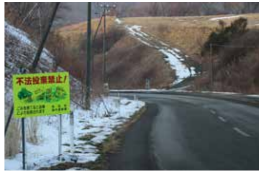
厚賀インターチェンジが開通し ゴミの投棄が増えた町道大狩部本郷井旗線
