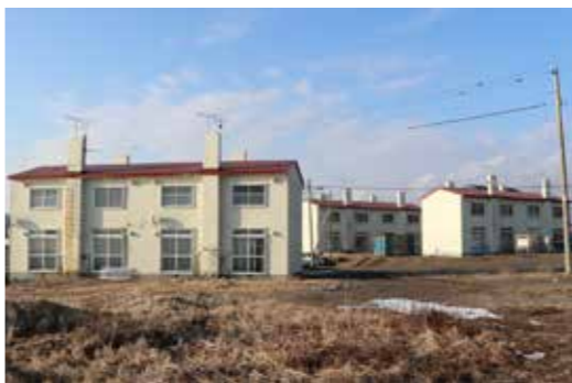
今後取り壊しを予定している汐見団地
