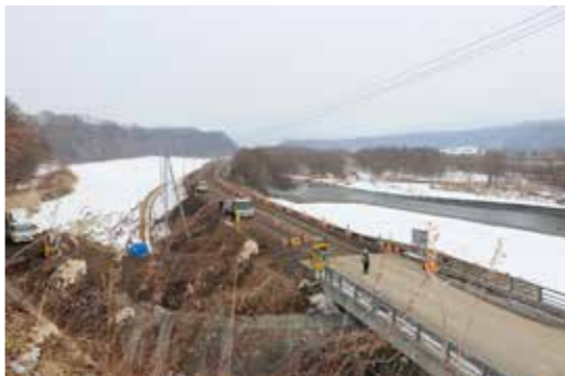
道道滑若新冠停車場線（若園堤防）道路改良工事の様子
