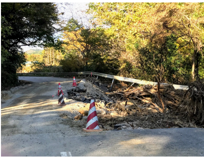
決壊した道路
