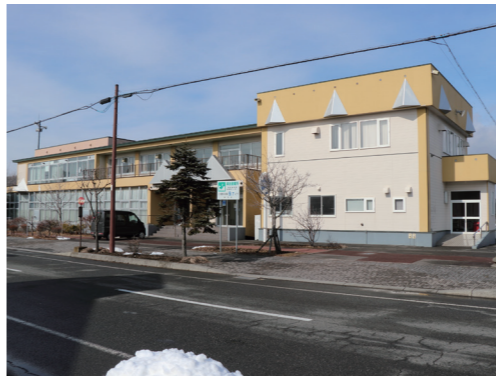
建築後約60年が経過し改修要望のあった『本町多目的交流センター』
