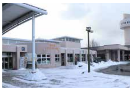
道の駅 サラブレッドロード新冠
