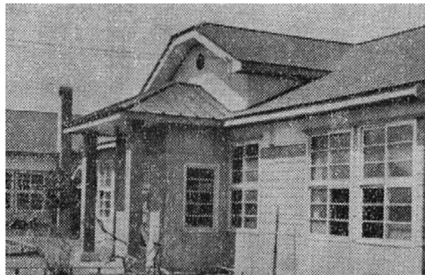
▼昭和26年に建設された庁舎。その後、昭和34年に焼失
