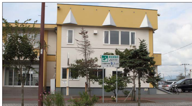
本町多目的交流センター 標高 9.7 メートル
