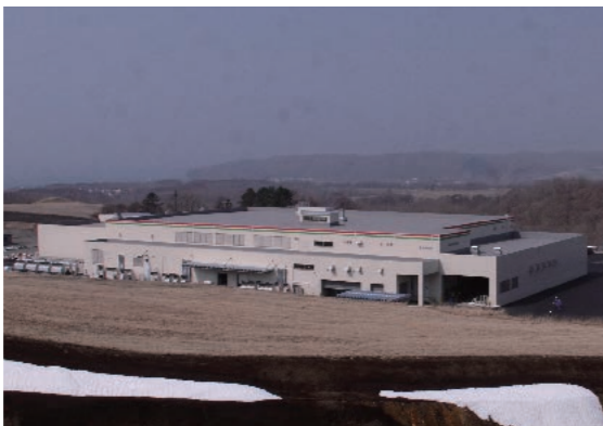
建設工事が進む日高食肉流通センター
