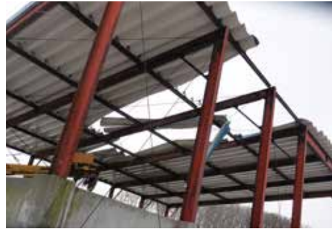
堆肥舎が半壊
