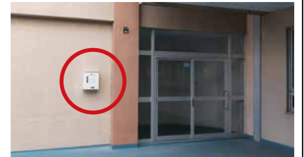
新冠小学校 2階体育館側玄関
