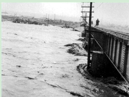
大水害時の新冠川濁流と鉄橋 昭和30年7月4日
