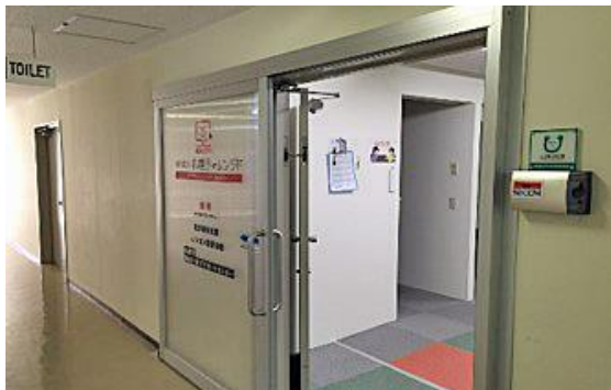
①入口の外側にスライドドアを外付け
