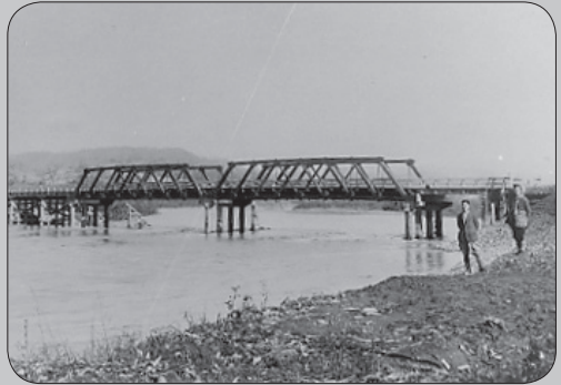
昭和11年頃の新冠大橋
